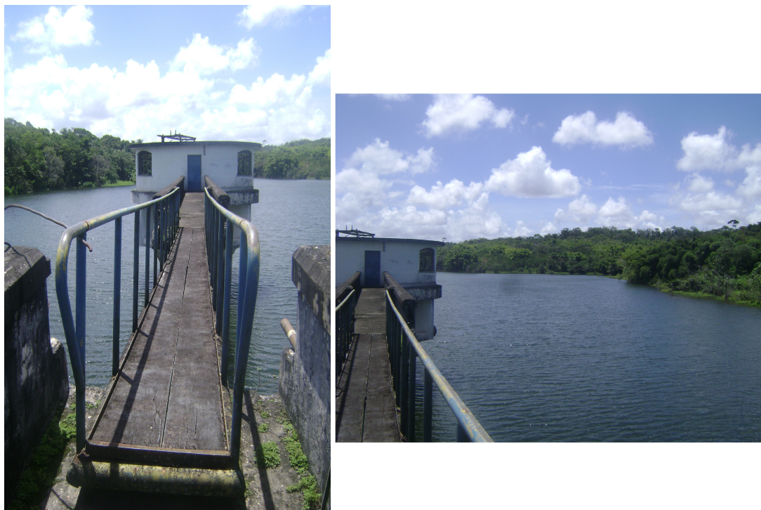
Figura 5– Barragem dos Macacos
