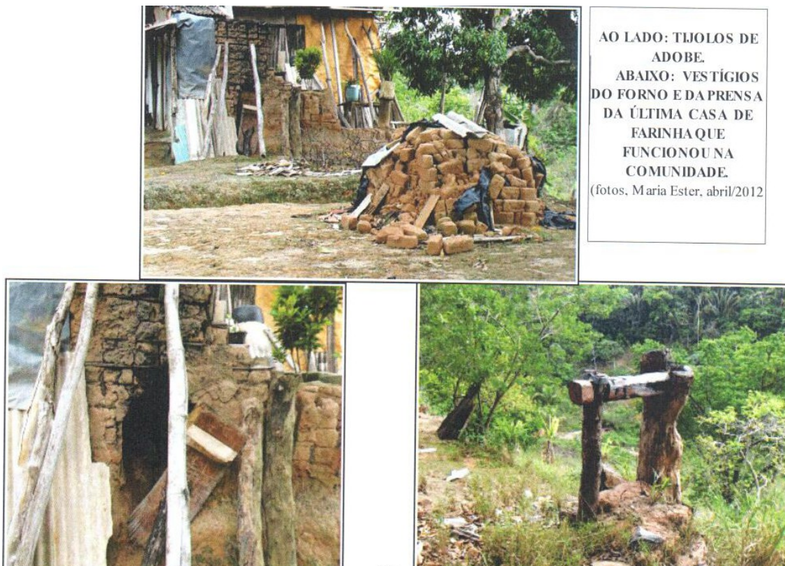
Figura 9 – Ruínas das habitações em Rio dos Macacos
